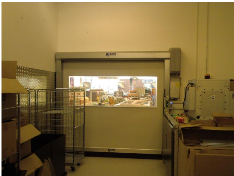
Foto: Brzopokretna PVC vrata, brzopokretna samopopravljajuća hladionička PVC vrata
