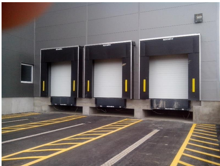
Foto: Pretovarne el. hidraulične rampe, dock shelteri, sekcijska vrata
