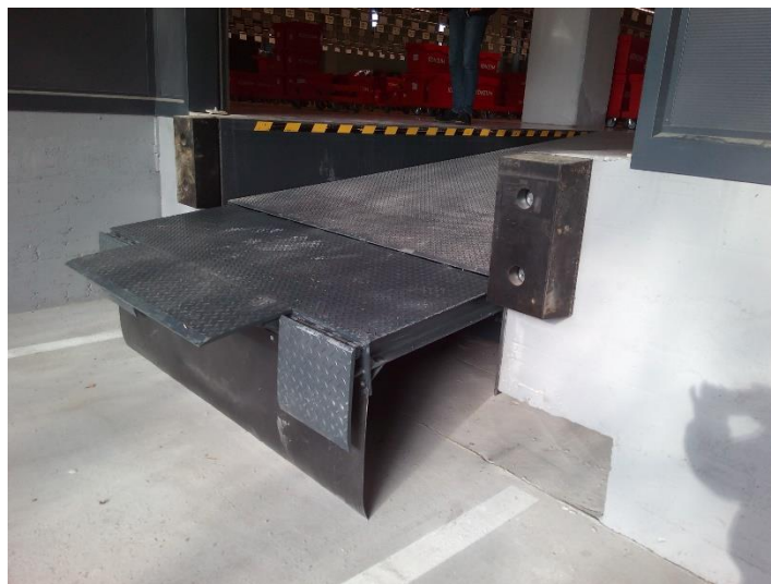
Foto: Pretovarne el. hidraulične rampe, dock shelteri, sekcijska vrata
