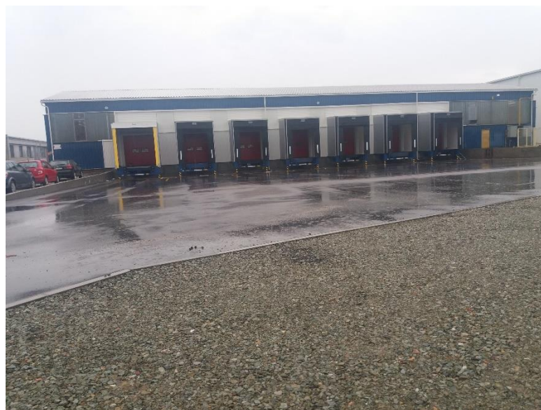
Foto: Pretovarne kućice, podizne platforme – škarasti stolovi
